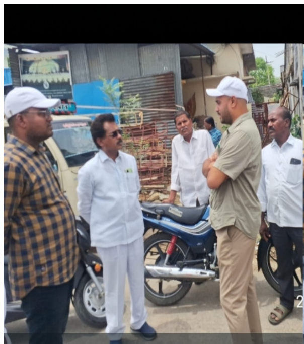
దోమకొండ, మే 30. ( ప్రజా దర్శి ) : కామారెడ్డి జిల్లా దోమకొండ మండల కేంద్రంలోని బీబీపేట రోడ్డులో జరుగుతున్న అండర్ గ్రౌండ్ డ్రైనేజీ నిర్మాణం పనులను సర్పంచ్ ఐరేనీ
